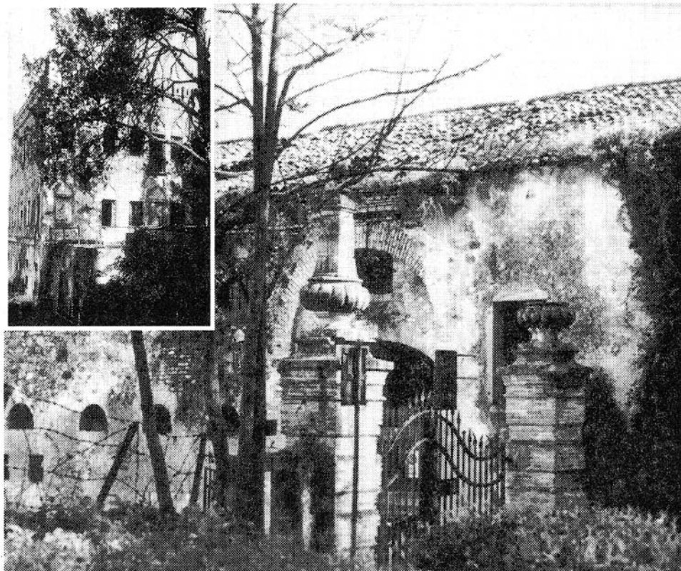
Due scorci di Villa Draghi che evidenziano il completo degrado nel quale è abbandonata
