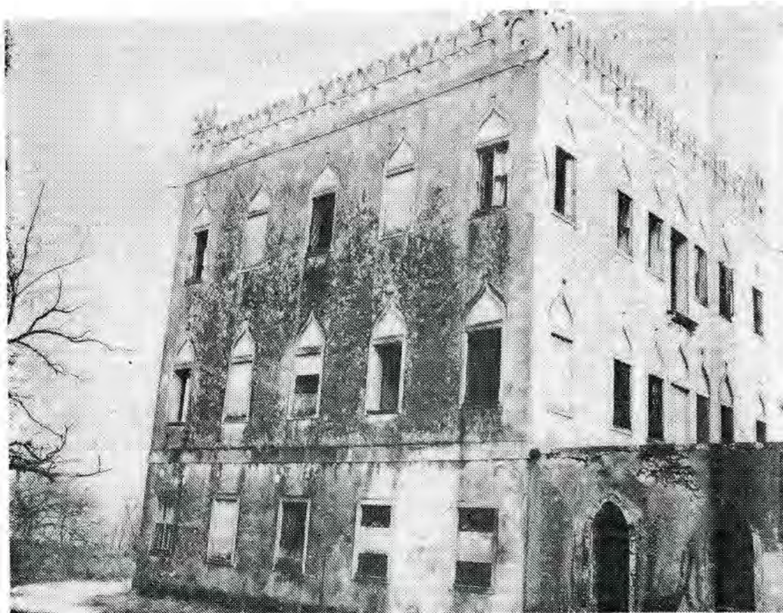
Villa Draghi a Turri di Montegrotto: lo stato di decadimento è evidente. (Foto Vincenti)
